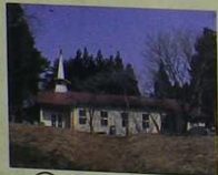
② 大籠カトリック教会 Okago Catholic Church
